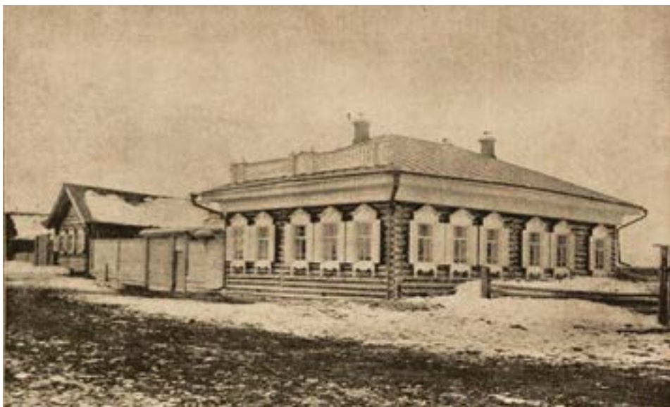
Дом для причта в пос. Александровском Томской губернии, конец XIX в. Положение церковного и школьного строительства в районе Сибирской железной дороги на средства фонда имени императора Александра III к 1 января 1900 г. СПб., 1900. Рис. к с. 29
